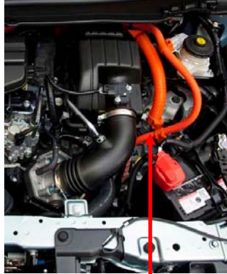
Civic AC Kompresör Yüksek Voltajlı Kablosu
