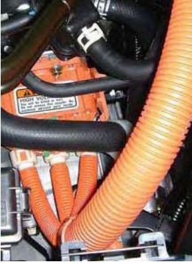
Yüksek Voltajlı Kablo ile Motor Bağlantısı
