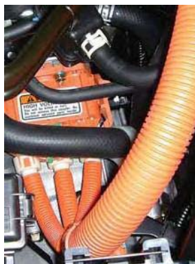
Högspänningskablar anslutna till elmotorn
