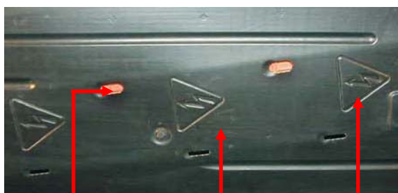
Högspänningskabel som syns
