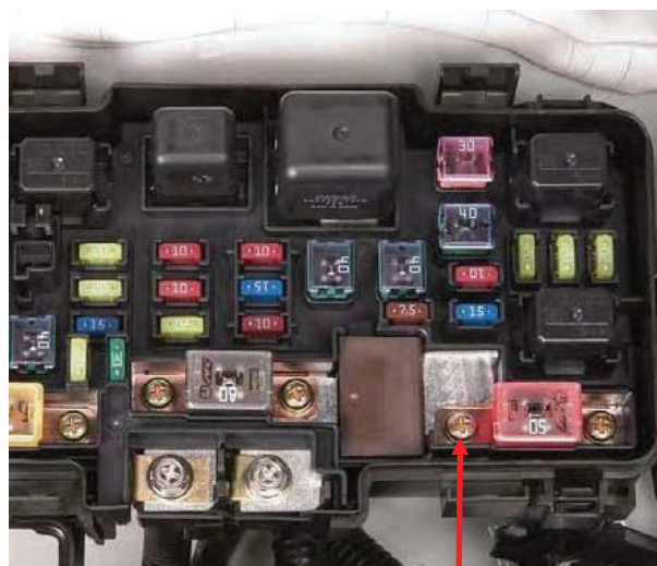
Tornillos del fusible principal
